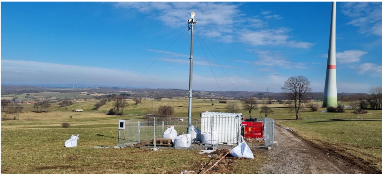
Abbildung 13: Installiertes System IDF 1 im März 2022
