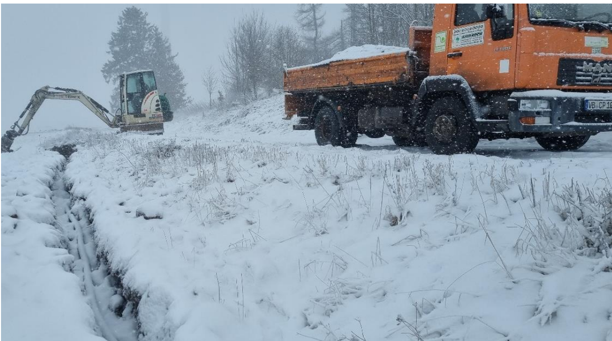
Abbildung 11: Schließen des Kabelgrabens zwischen beiden IDF Standorten
