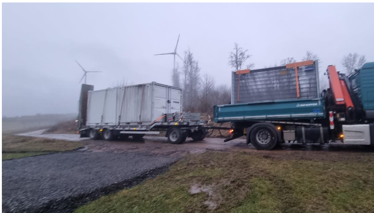
Abbildung 8: Anlieferung des IDF-1 über bestehende Straßen/Wege
