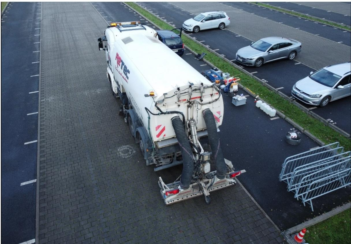
Abbildung 34: Regenerierung von Sickerpflaster durch Hochdruckspülung/Absaugung bei großen Flächen (Präsentation Berding, 2022)
