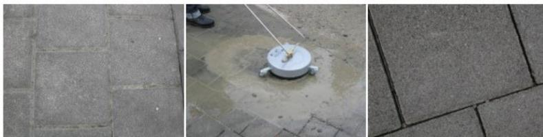
Abb. 92: Objekt 21: zugesetzte Fläche (li.), Hochdruckreinigung (Mitte), gereinigte Fläche (re.)
