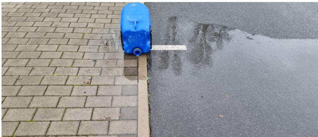
Abbildung 6: Sickerpflaster aus durchlässigen Pflastersteinen als Parkplatz mit angrenzender Asphaltfahrbahn (Bildquelle: Sieker)
