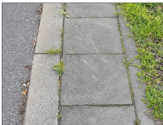
Abbildung 2: Pflaster mit dichten Fugen (Bildquelle: Sieker)
