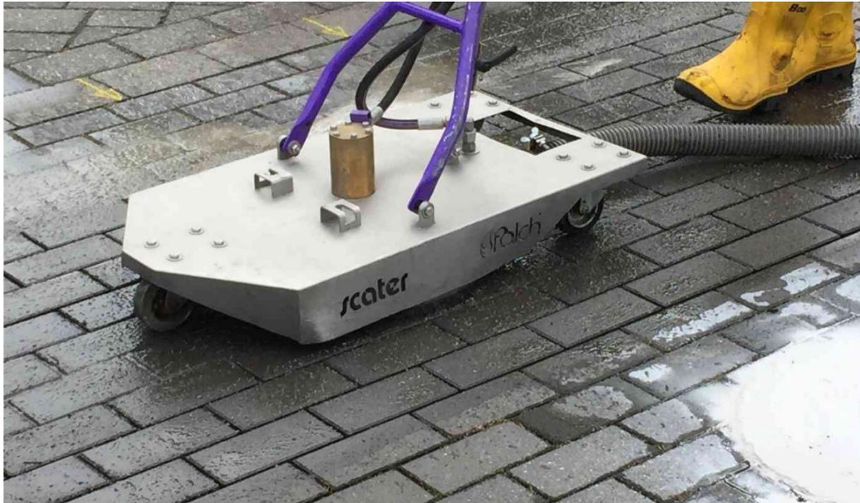
Abbildung 33: Regenerierung von Sickerpflaster durch Hochdruckspülung/Absaugung bei kleinen Flächen (Präsentation Berding, 2022)
