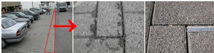
Abb. 79: Objekt 19: zugesetzter Bereich (li.), Eingeschlammtes (Mitte), sauberer Bereich (re.)
