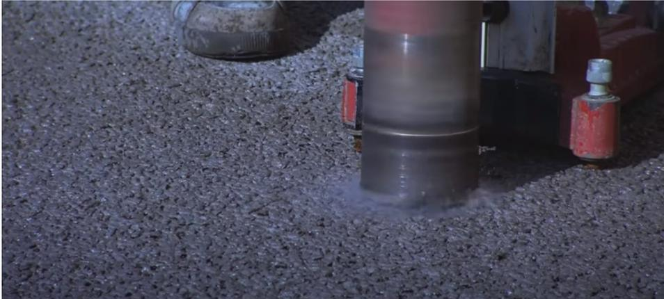
Abbildung 14: Detailaufnahme von Dränbeton. Quelle: Dränbeton – Versickerungsfähige Verkehrsflächen aus Transportbeton (YouTube 2015)
