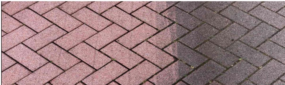
Abbildung 35: Regenerierung von Sickerpflaster durch Hochdruckspülung/Absaugung – Vergleich (Präsentation Berding, 2022)
