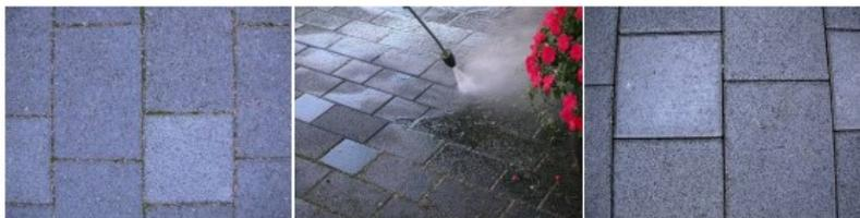
Abb. 93: Objekt 24: verschmutzte Fläche (li.), Hochdruckreinigung (Mi.), gereinigte Fläche (re.)
