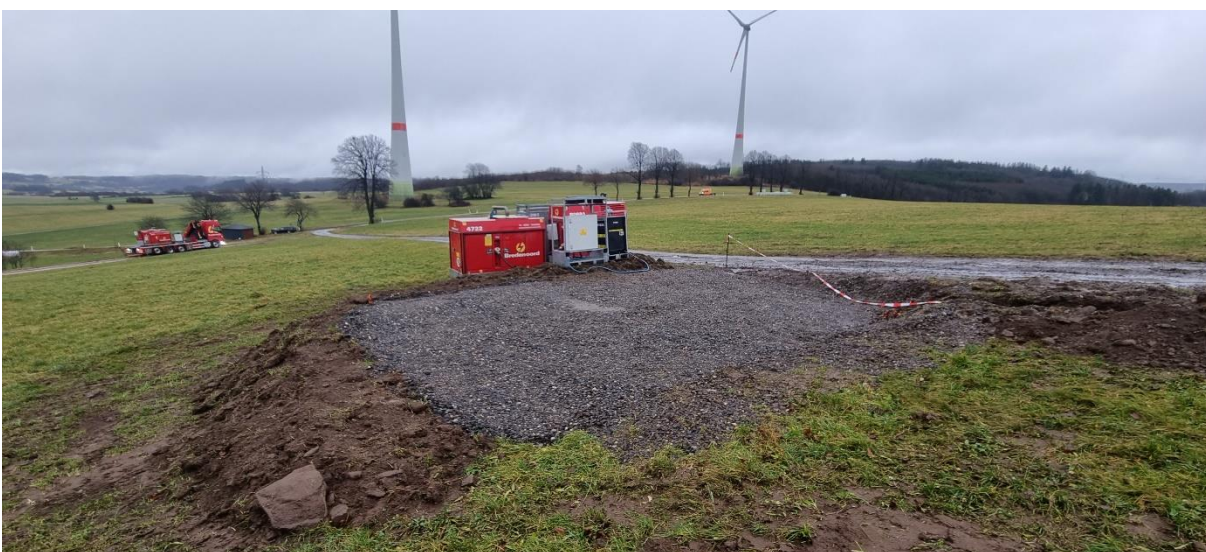
Abbildung 9: Anlieferung und Aufbau der Stromversorgung am Standort IDF-1, im Vordergrund die temporär geschotterte Standfläche (154 m 2 )
