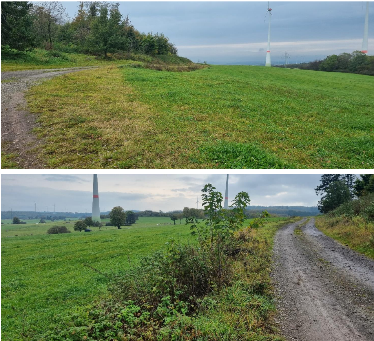
Abbildung 7: Verlauf des Kabelgrabens zwischen IDF 1 und 2; die Ruderalstrukturen wurden nicht in Anspruch genommen
