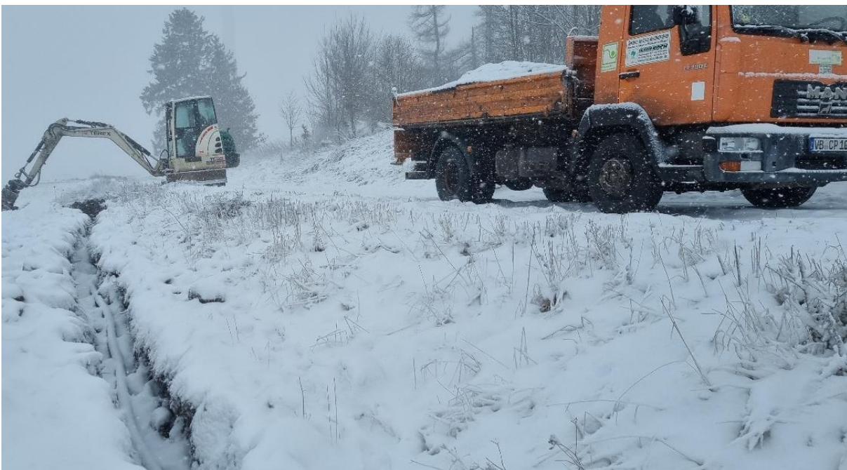
Abbildung 11: Schließen des Kabelgrabens zwischen beiden IDF Standorten
