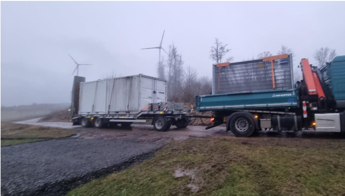
Abbildung 8: Anlieferung des IDF-1 über bestehende Straßen/Wege
