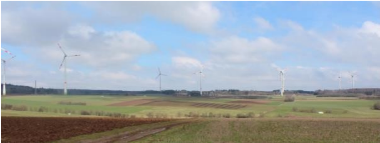
Abbildung 11: Beobachtungspunkt 9, Blick auf beide Windparks (Richtung Nord-Ost)
