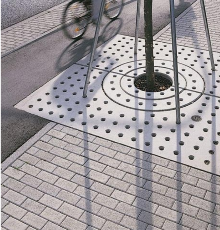
Abb. 18: Eine mitwachsende Baumscheibe, die dem Baum ausreichend Raum gibt, © www.beton-pfennig.de/produkte
